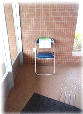
正面玄関 椅子
